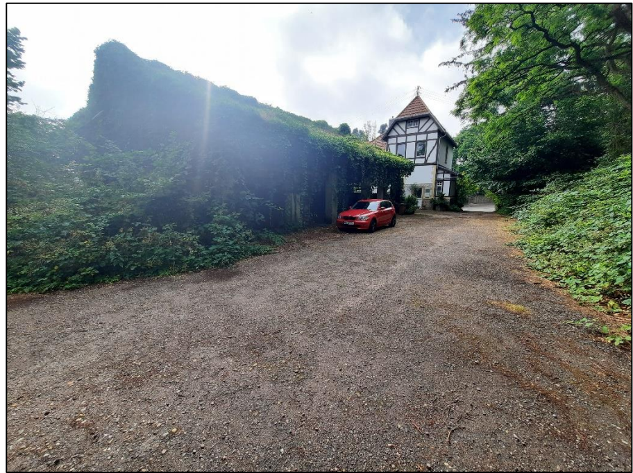
Foto 10: Die Scheune und das zu erhaltende Wohnhaus von Norden aus betrachtet.
