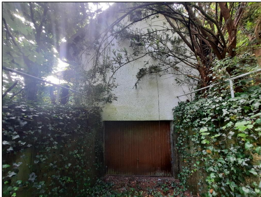
Foto 16: Das nördliche Wohngebäude ist zudem unterkellert und könnte sich daher auch als Winterquartier von Fledermäusen eignen.
