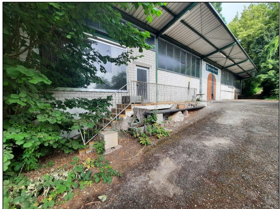
Foto 11: Weiter nördlich entlang des Asphaltwegs steht diese Halle/Werkstatt. Auch sie bietet Quartierpotenzial für Fledermäuse sowie Nistplatzpotenzial für Gebäudebrüter. Direkt davor finden sich außerdem Versteckmöglichkeiten für Reptilien.
