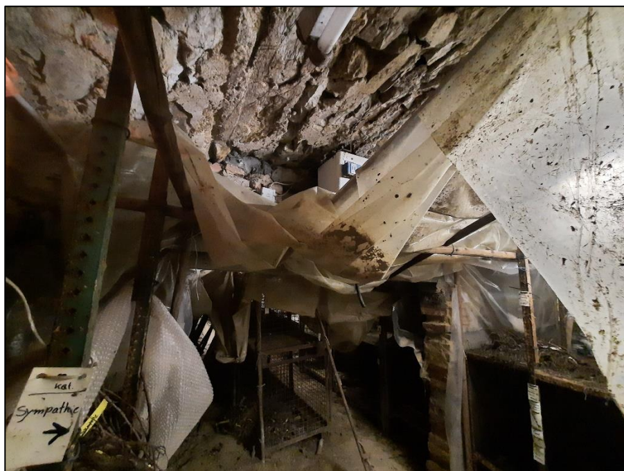
Foto 5: Der Erdkeller ist vollständig ausgemauert. Er bietet großes Potenzial als Überwinterungsstätte von Fledermäusen, da er zahlreiche auch tiefere Mauerspaltten enthält.
