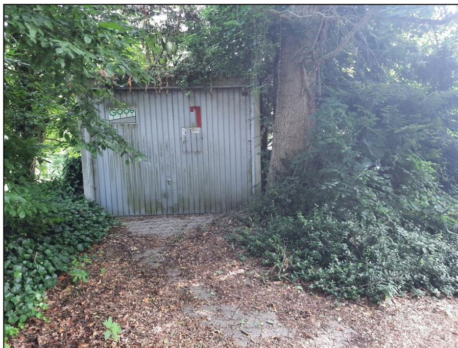
Foto 18: Diese Einzelgarage am nördlichen Ende soll ebenfalls abgebrochen werden.
